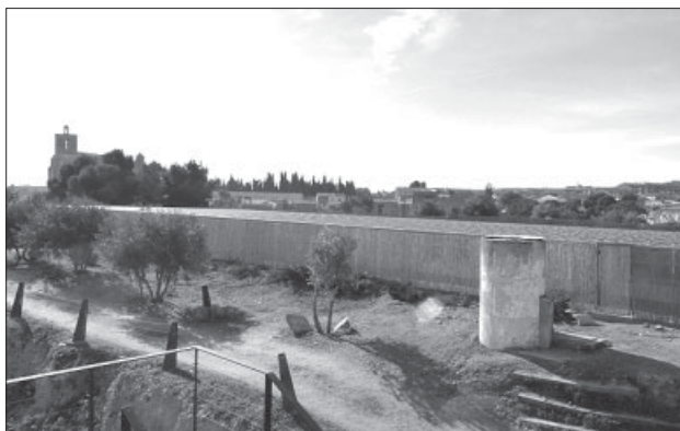
Obres de cobriment dels dipòsits
