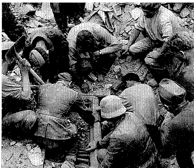
Refugio sepultado por los escombros de una casa vecina
